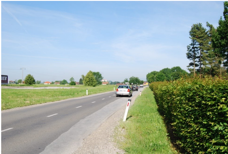
Slika 15: Nevarni del Rogozniške ceste
