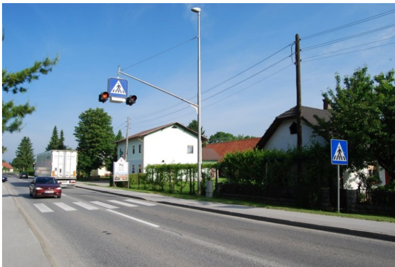
Slika 3: Prehod na Ormoški cesti
